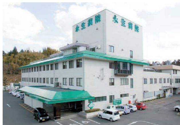
永生病院 130床(一般病棟 40床・介護医療院 90床)
